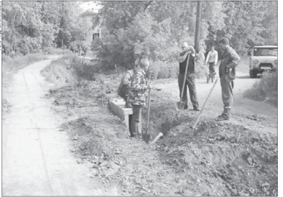
За перекидным мостом по улице Строителей бригада ПЧ-11 ведёт работы по обустройству водоотводной канавы.
